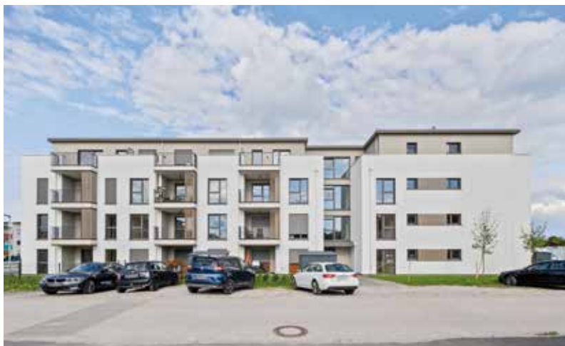
Fotos: ELK BAU GmbH
